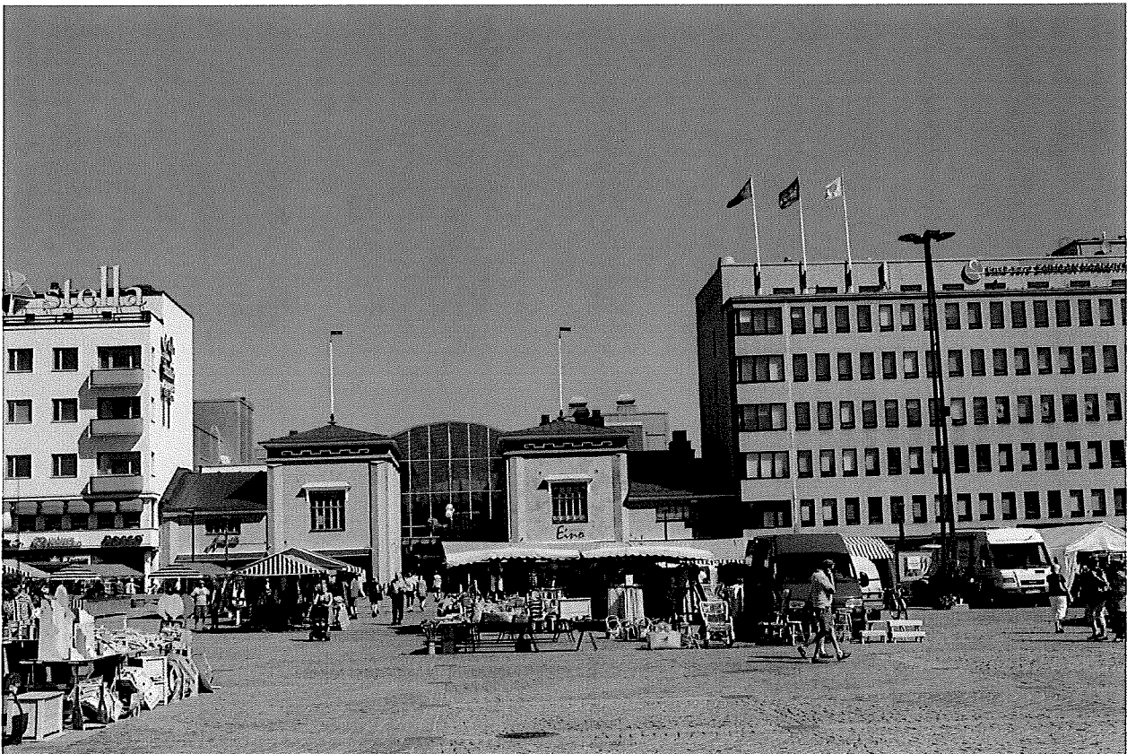
Mikkelin tori ja kauppakeskusten väliin rakennettu katettu tila, jossa sijaitsee mm. Kauppahalli. Torin ja kauppakeskusten välissä kulkee kävelykatu.
