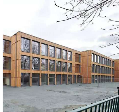
Grundschule Sewanstrasse 43 in Berlin
